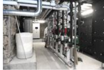
Bild 9: Die Technikzentrale liegt unmittelbar unterhalb des Konzertsaals
