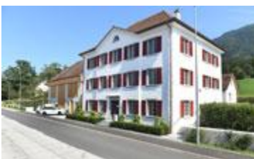
Bild 2: Das denkmalgeschützte Gebäude wurde 2022/24 aufwändig saniert
