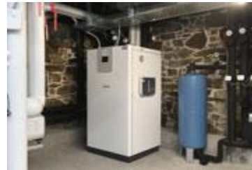
Bild 10: So leise wie möglich: Die Erdsonde-Wärmepumpe WPE-I 87 H 400 von STIEBEL ELTRON
