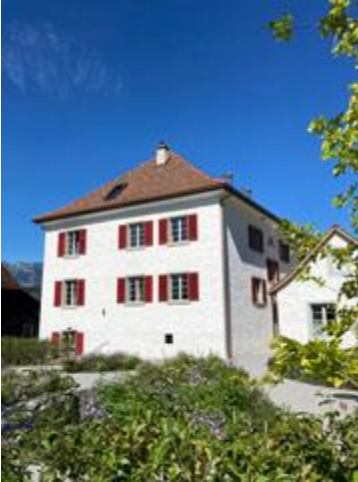
Bild 6: Das revitalisierte Objekt besteht nun aus vier verschiedenen Gebäuden
