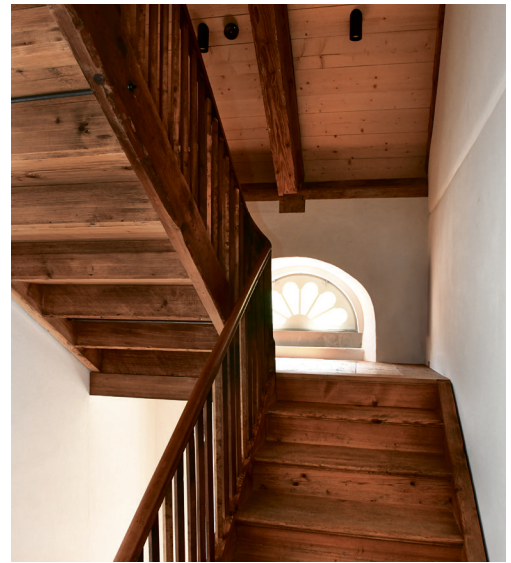
Die historische Treppe zum Dachraum.
