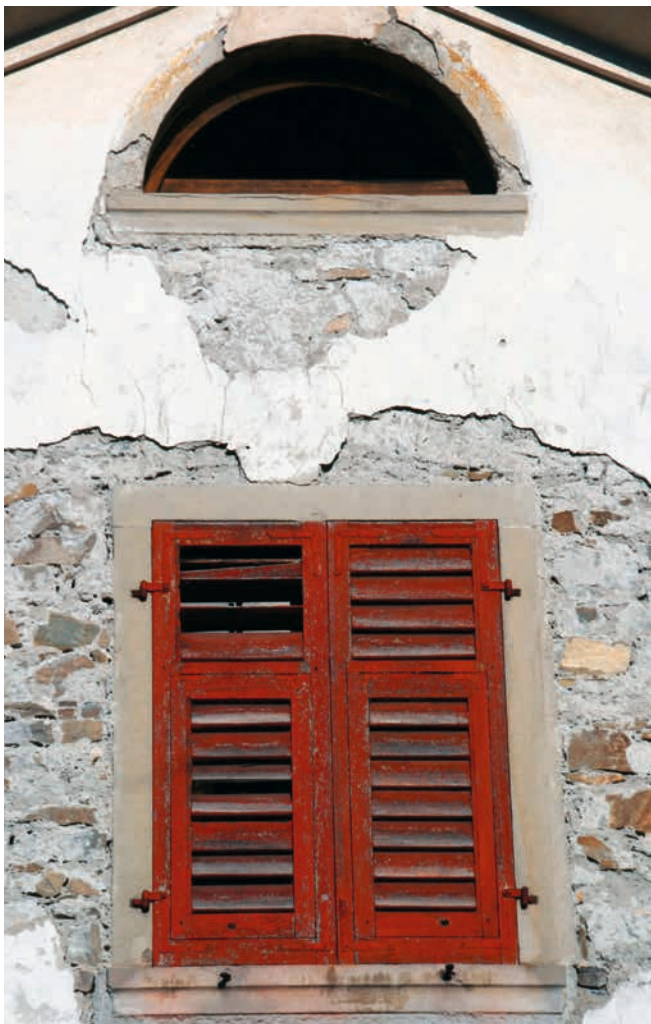
Abb. 3: Sandsteingefasstes Halbkreisfenster und Fenster mit Fensterläden aus der Entstehungszeit des Wohnhauses (1837); Foto vom Mai 2013.
