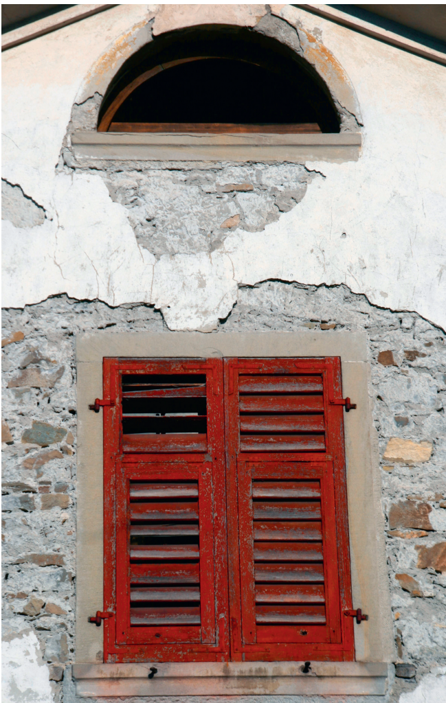
Sandsteingefasstes Halbkreisfenster und Fenster mit Fensterläden aus der Entstehungszeit des Wohnhauses (1837); Foto vom Mai 2013.
