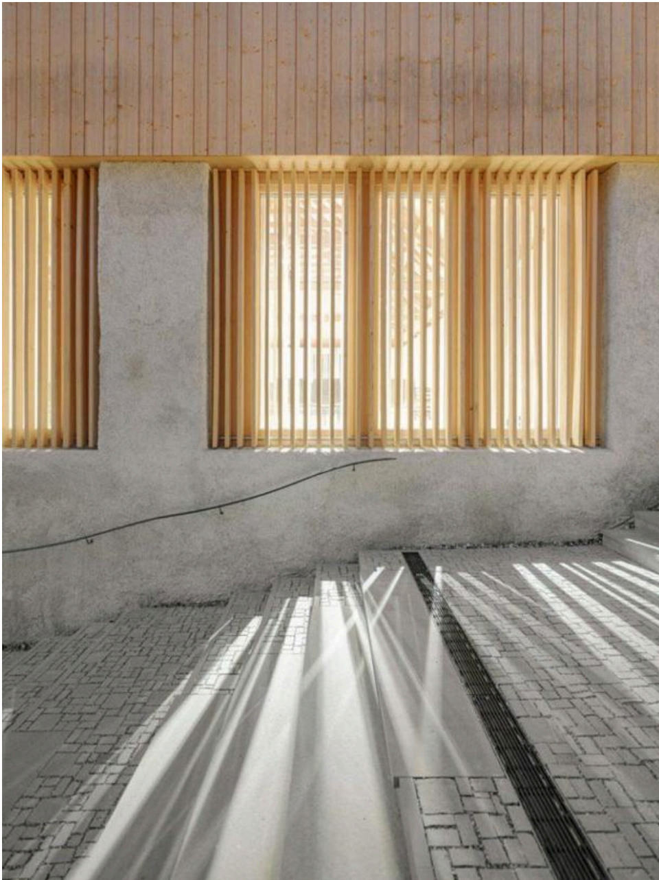
Die historische Holzfassade der Stallscheune hat man durch verstellbare Holzlamellen neu interpretiert.
