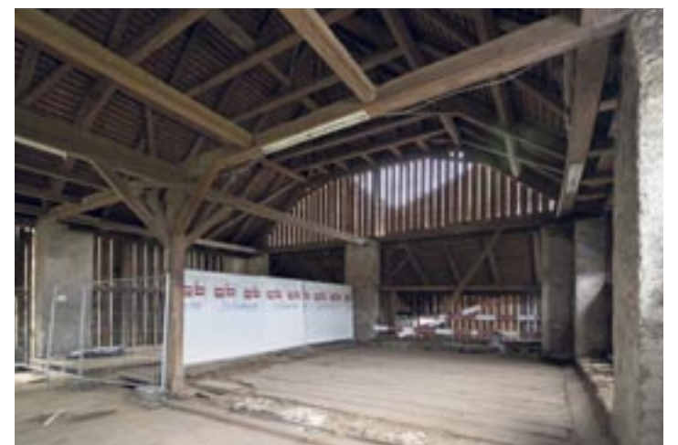
Im ehemaligen Stallgebäude entsteht ein Konzert- und Proberaum.
